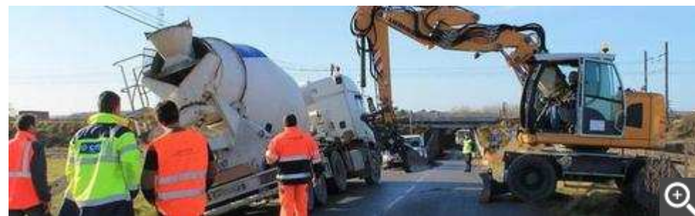
Pour permettre l'évacuation du véhicule, le béton a dû être vidé dans le fossé.
